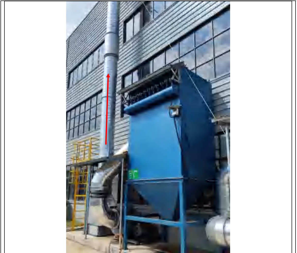
抛丸粉尘布袋除尘器装置
